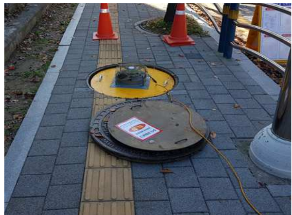
내용 맨홀 내,외부 뚜껑 상태양호
